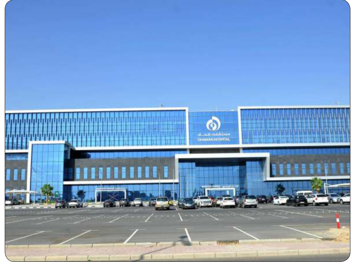
مبنى مستشفى «ضمان» بالأحمدي
