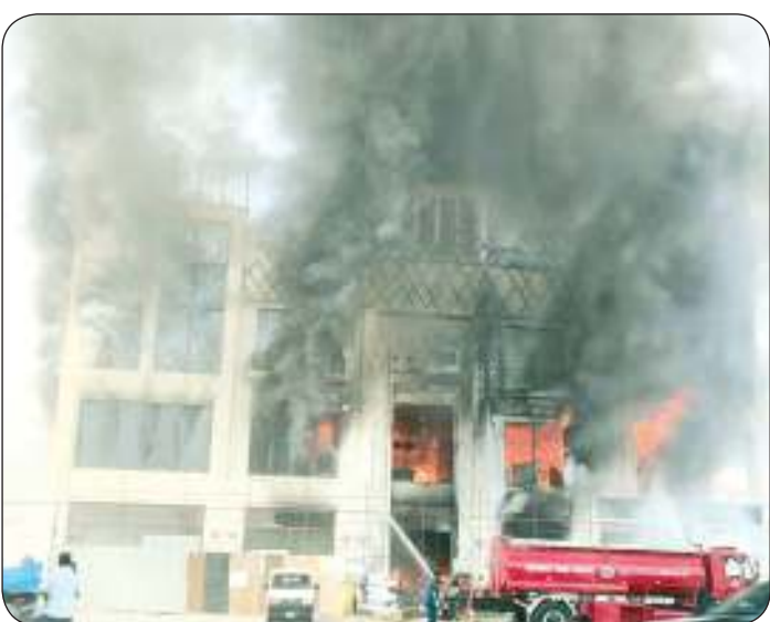
فريق الاطفاء تكافح الحريق في المجمع
