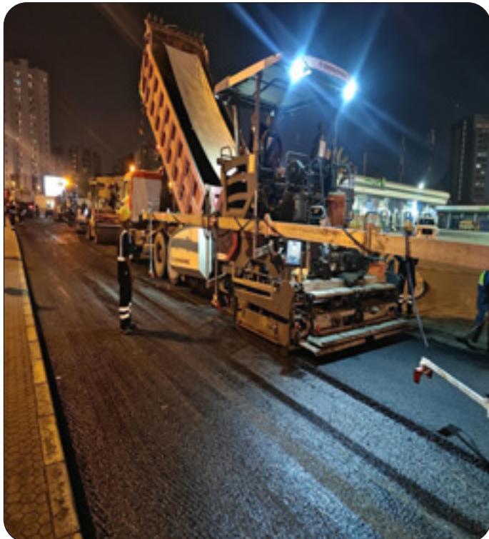
■ جانب من أعمال صيانة الطرق
