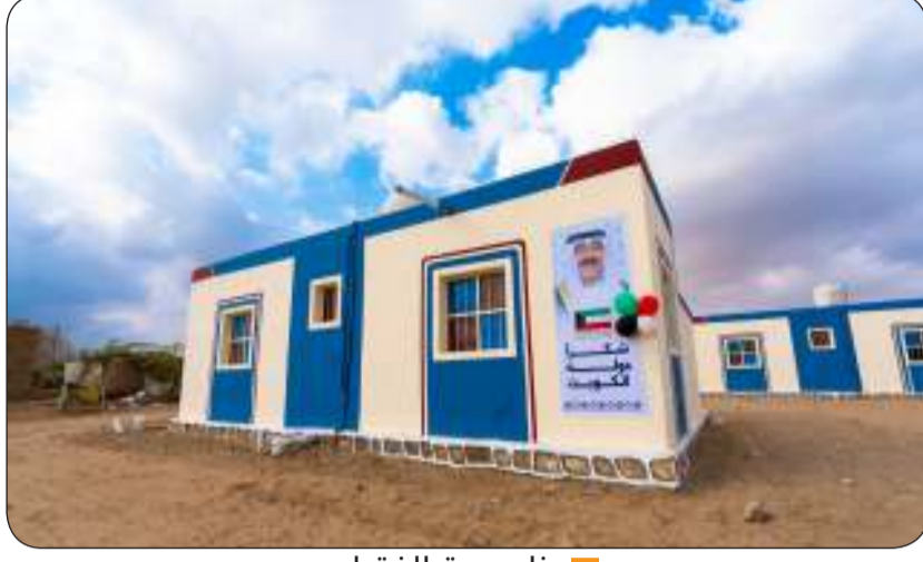
■ بناء بيوت الفقراء
