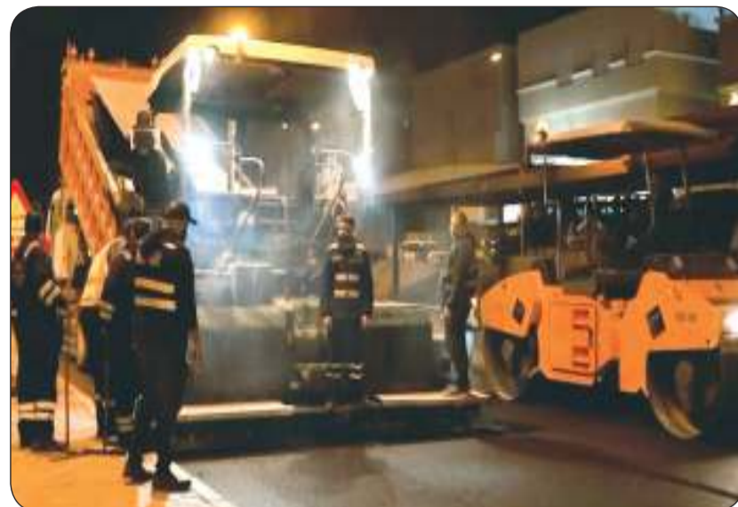
مواصلة أعمال الصيانة الجذرية لطرق منطقة عبدالله المبارك ضمن العقود الجديدة
