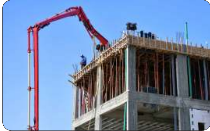
صب الخرسانة بدون إشراف أو وجود المقاول وبدون التقيد بشروط السلامة
