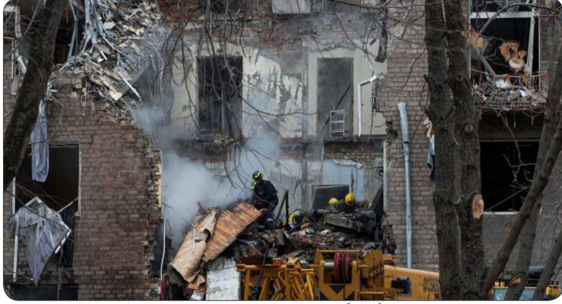
فرق الإنقاذ تبحث بين أنقاض أحد المباني التي استهدفها القصف الروسي في كريفني ريه
