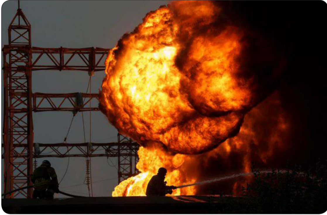
قصف روسي على محطة كهرباء بمقاطعة دنيبرو بتروفسك في أوكرانيا
