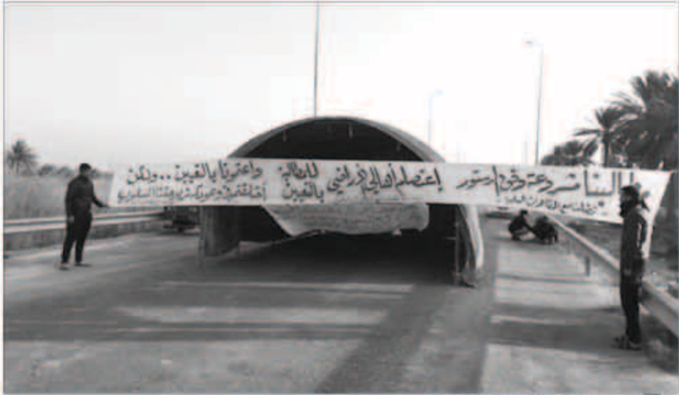
متظاهرون يغلقون محطة الكهرباء في كربلاء
