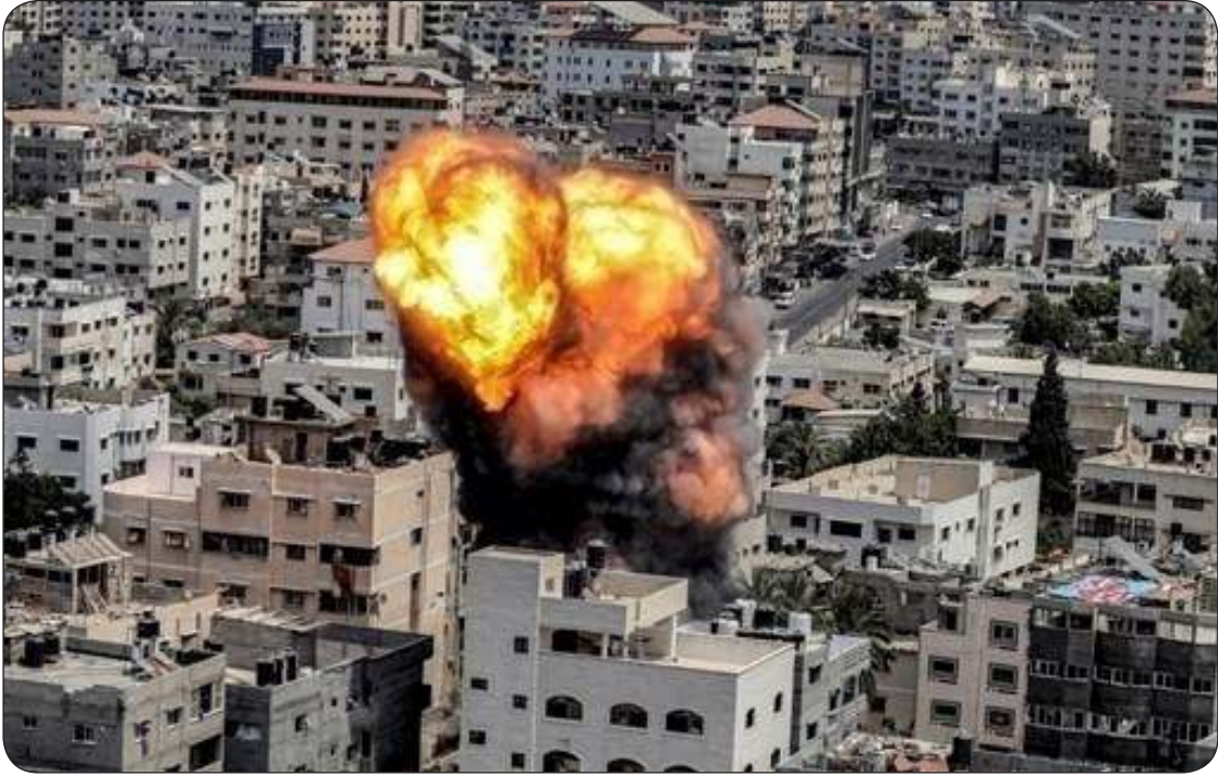
نيران ملتهبة في مبنى تعرض للقصف بغزة
