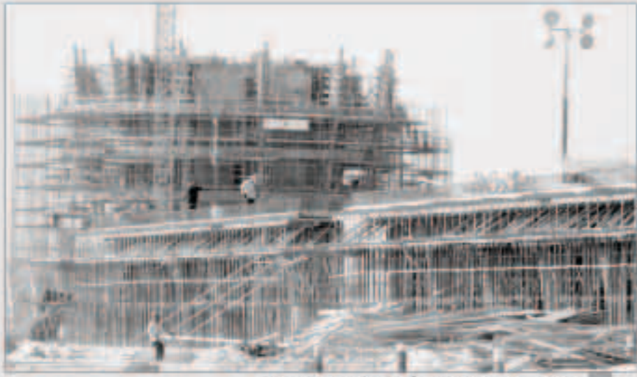
المشروع يخص بإنشاء المباني وأعمال الطرق والبنية التحتية
